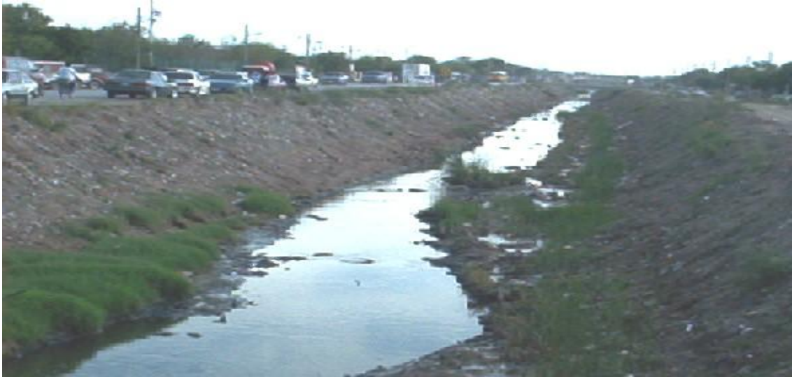
Figura 2.- Drenaje 20 de Noviembre
